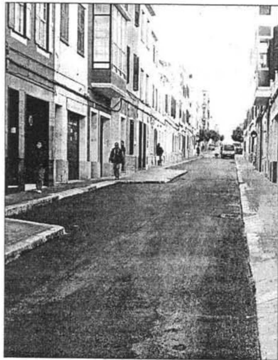
Mejorando el firme para los vehículos La capa asfáltica que se dio ayer es el primer paso para poder restablecer la circulación normal en unos días. ■ Foto: AJUNTAMENT DE MAÓ
