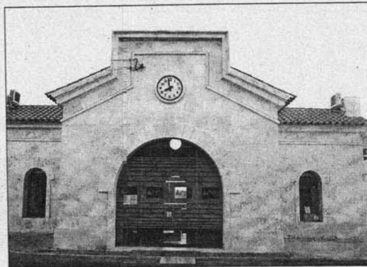
El nuevo reloj se ha instalado en la fachada de la casa del contra-maestre de Fornells.
