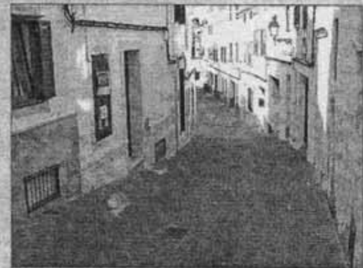
El Carrer de S'Arraval cuenta ya con el nuevo empedrado y con un saneamiento interior.
