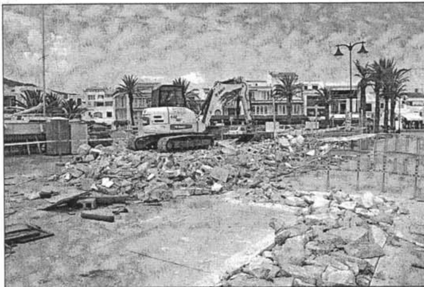
La excavadora limpió ayer el terreno en el que se ubicarán los dos depósitos. Foto: GISELA
