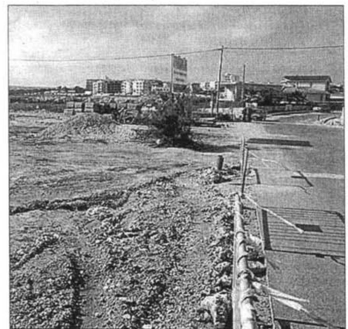
OBRAS. Las máquinas excavan en la zona de la futura terminal
