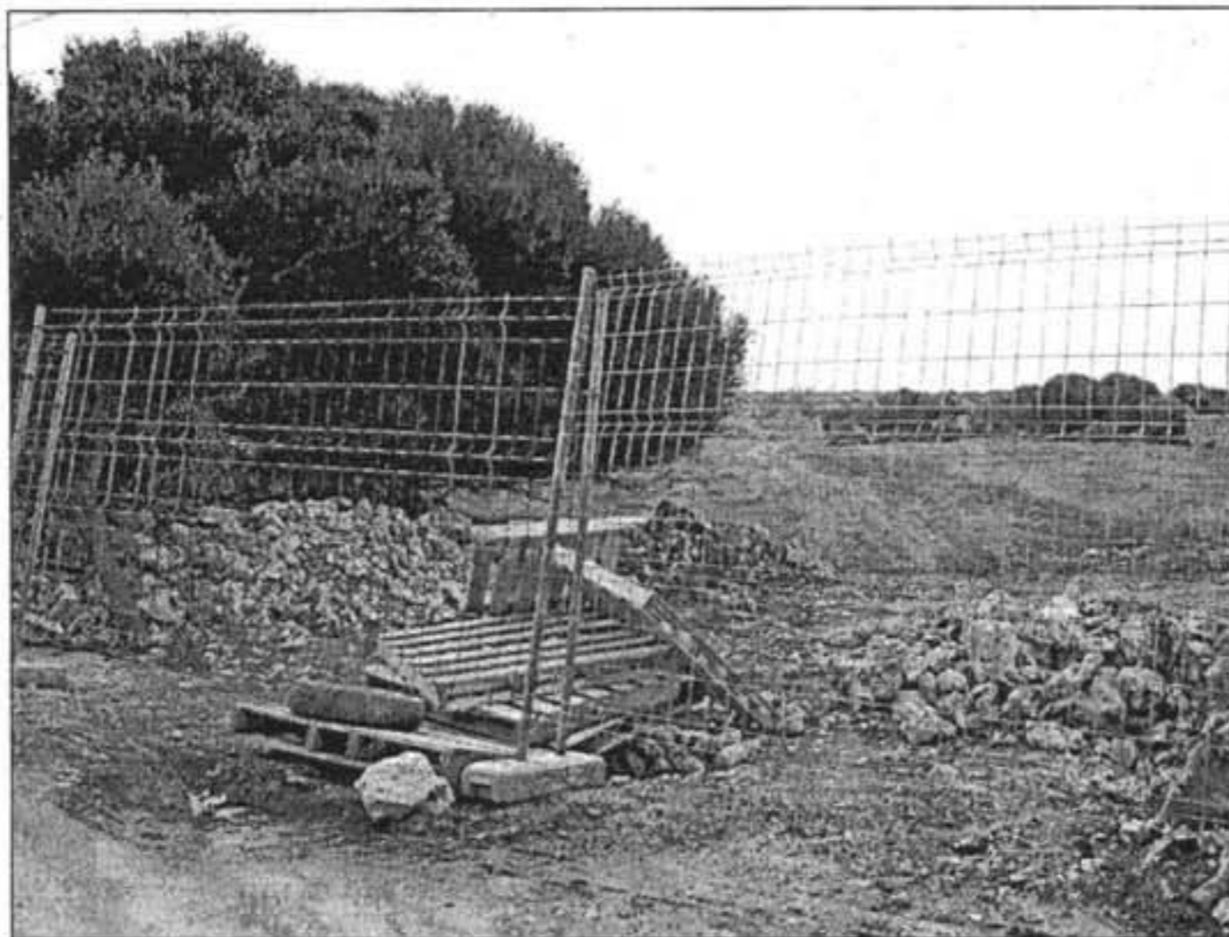
El parque solar de Son Salomó es el que está más avanzado, ya en obras.
