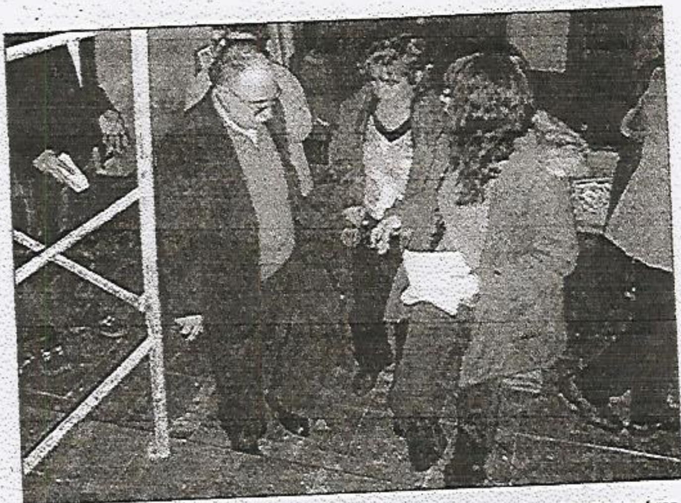
El teatro de Fornells, propiedad de la Iglesia católica, se encuentra actualmente en obras.
